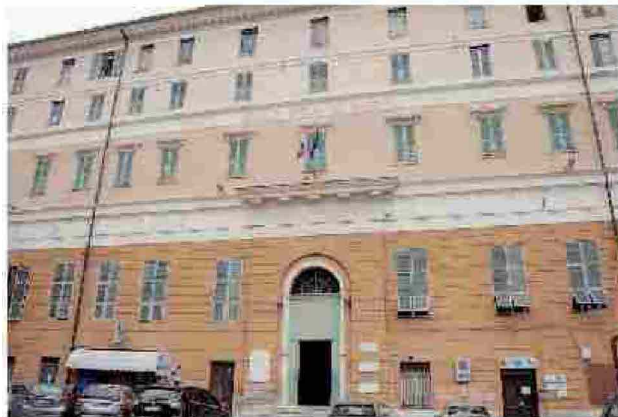
Lo storico Liceo Classico De Amicis che necessita di interventi
